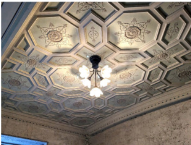
正面玄関ポーチ上部の天井装飾
