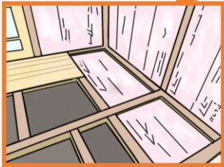
外壁・床の断熱工事
