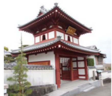
写真 31: 美馬市真楽寺鐘楼門(現状) 最後列では、(写真では見えないが)最前列同様中央一間筋の控柱を省略している。近年改築され、桁行が拡大されたが、柱の位置関係は維持されている。
