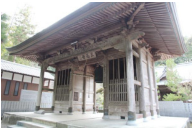
写真 24: 三角寺仁王門正面平側・右妻側・軒裏見上げ
