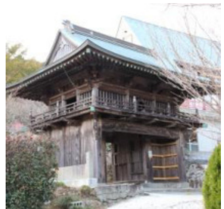
写真 30: 上板町大山寺鐘楼門
