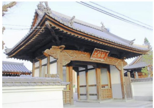
写真 26: 五明院西門正面平側・左妻側・軒裏見上げ
