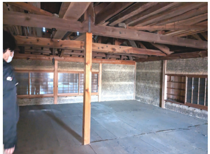
2階は仕上げがない
