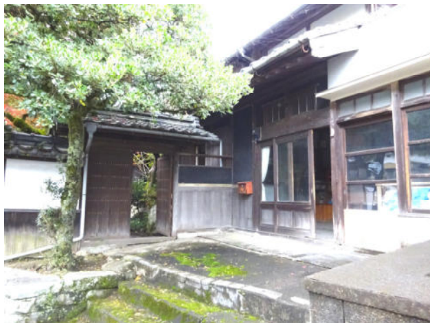
古本家玄関周り (右側引き戸が、店舗入口)
