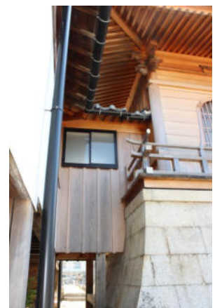
写真8：来迎寺太鼓堂と渡廊の接続部
