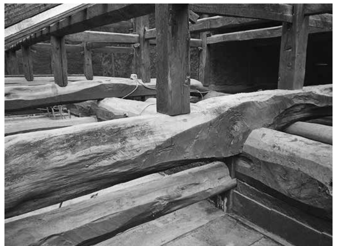
牟岐町内 古民家の複雑な小屋組
